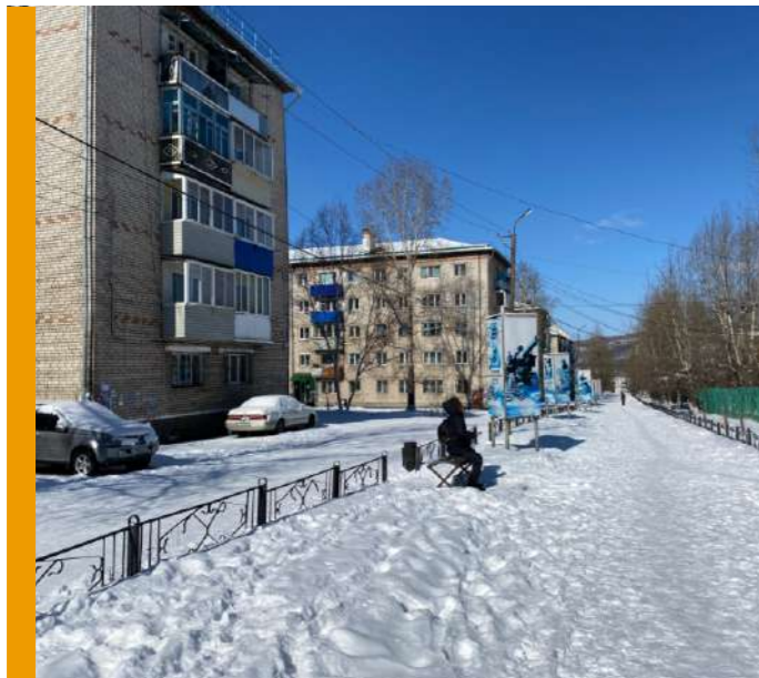
По Аллее славы проходит общественная дорога. Хаотично расставленные автомобили создают чувство небезопасности. Стенды с героями ВОВ выгорели и нуждаются в реставрации.
