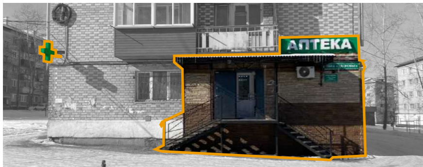
ВСТРОЕННЫЕ ПОМЕЩЕНИЯ НА 1М ЭТАЖЕ на примере фрагмента торцевого фасада дома по улице Комсомольская, 5 На данном фасаде устроены хорошая вывеска и кронштейн. Для законченного вида фасада рекомендуется продлить фасадную отделку до левого края.
